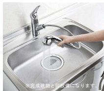
※完成建物と同設備になります。
